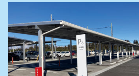
車幅の広い駐車場への設置例（柱間 3,650mm） 妊婦の方や高齢者の方など建屋への移動にご負担が大きい方の専用駐車スペース用
