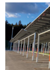
GL 不陸調整による 段違い設置例
